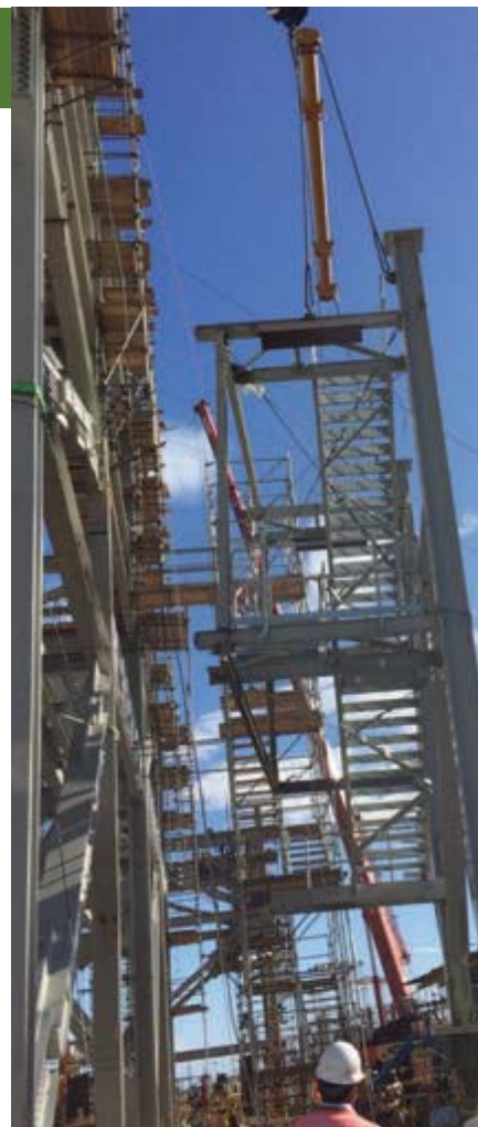
Emasa na construção da termoelétrica Punta Catalina, na República Dominicana.
